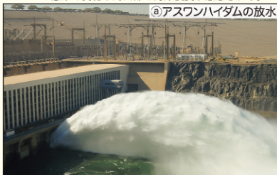
①アスワンハイダムの放水
