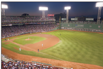
④ボストンのフェンウェイ・パークは、メジャーリーグの球場としては最古(1912年開業)である。
